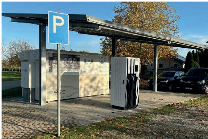
Bateria de fluxo de Vanádio da CellCube Potência 10kW Capacidade de energia: 100kWh
